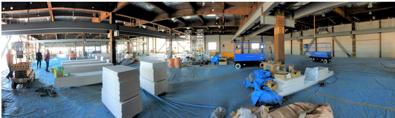
建屋内部状況
